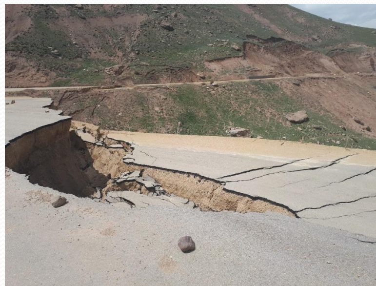
شکست جاده به دلیل لغزشی
