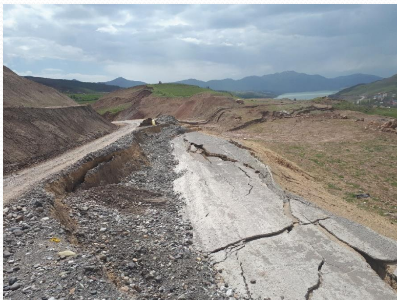
شکست و جابه‌جایی جاده به دلیل لغزشی بودن دامنه در محل ورودی طالقان
